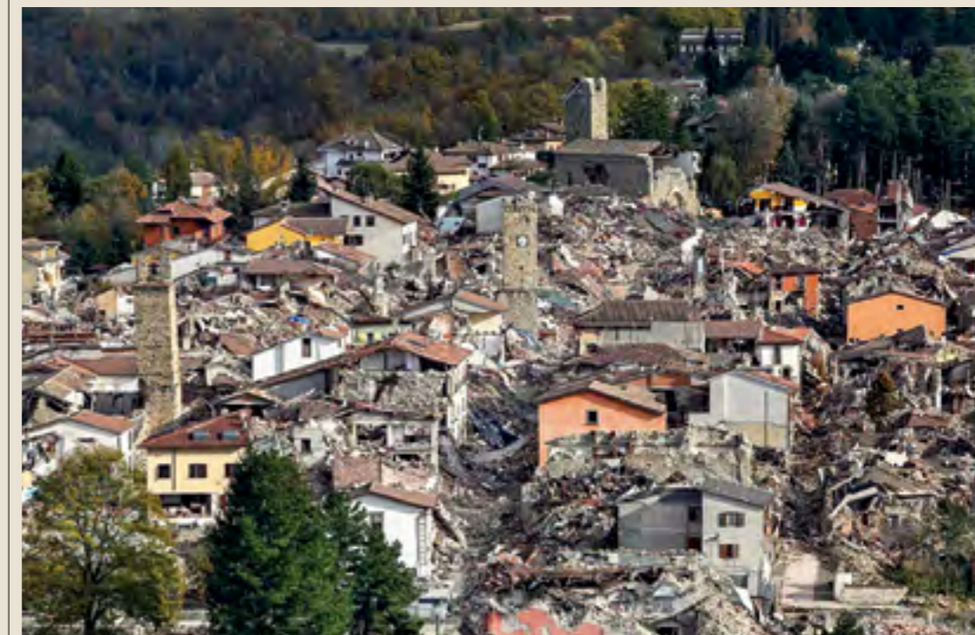
Terremoto 2016. Il centro storico di Amatrice.
