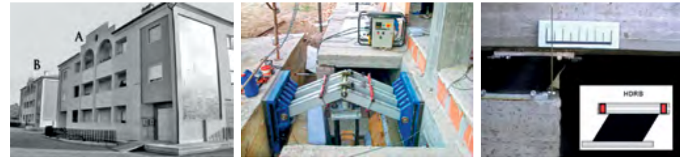
Figura 5. Edificio testato nel comune di Rapolla e particolare del sistema di isolamento alla base con HDRB.
