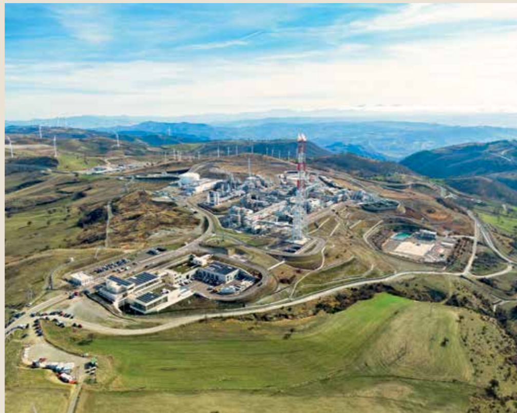
Figura 3. Vista sul sito estrattivo di Tempa Rossa, Corleto Perticara.
